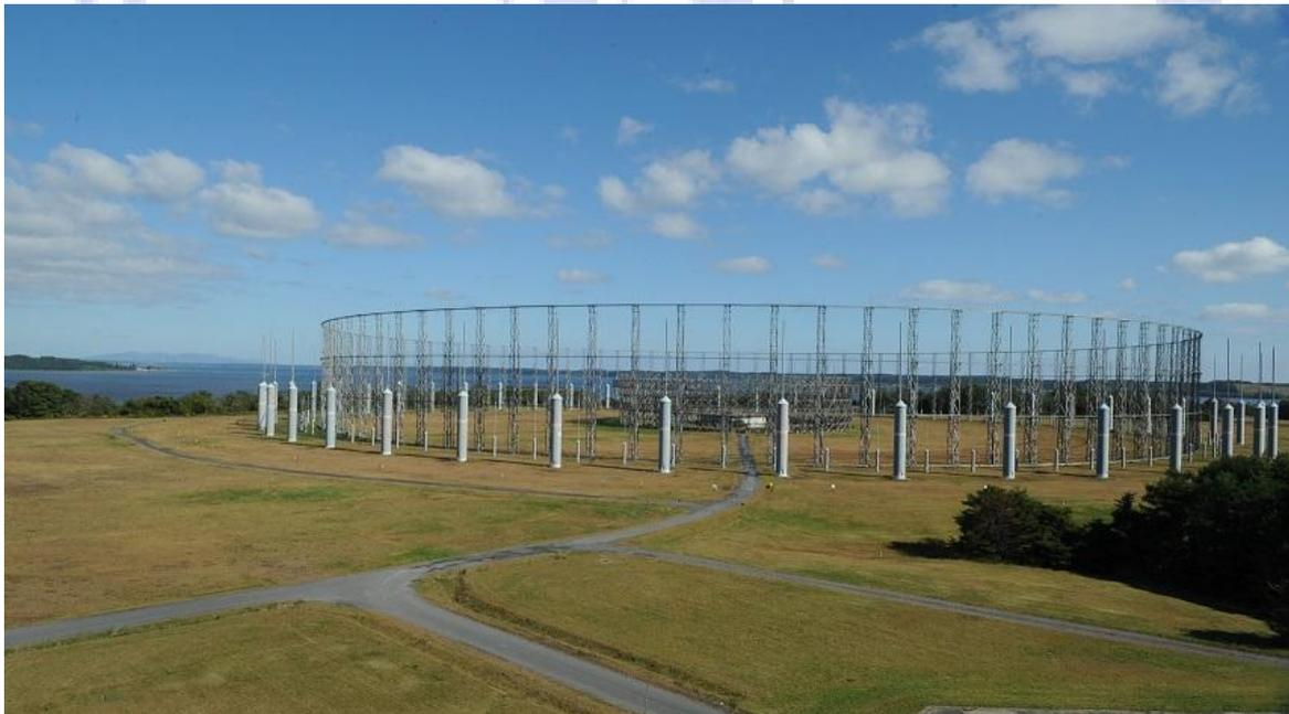
Imagem 02: A enorme antena com cerca de 440 metros de diâmetro e cerca de 40 metros de altura, que foi instalada na base aérea de Misawa no Japão -
